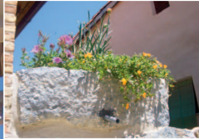
• Detalle de la intervención
