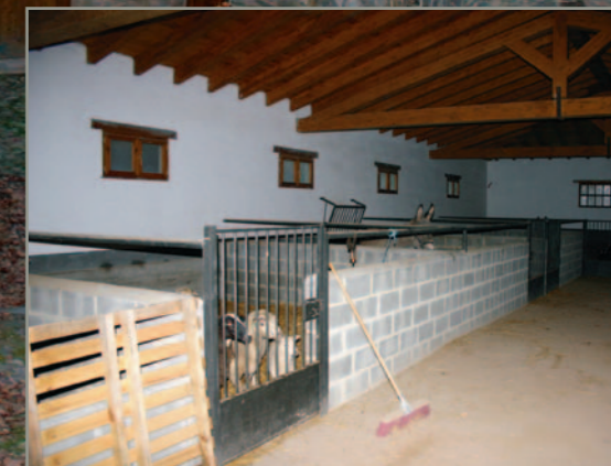
•• Detalle de la intervención
