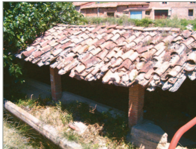
Aspecto anterior a la intervención
