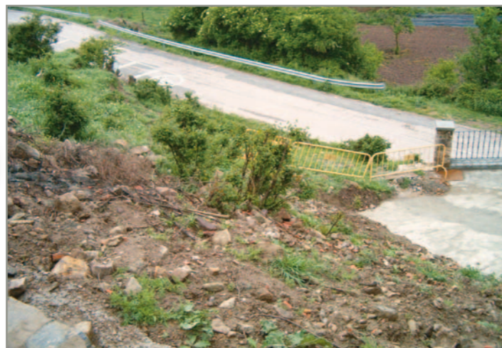
Aspecto anterior a la intervención
