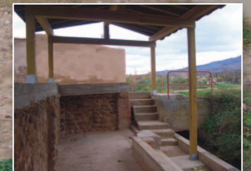
Detalle de la intervención
