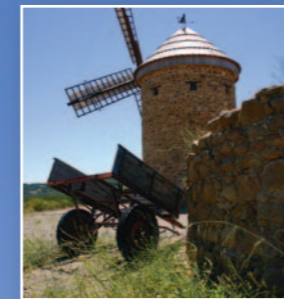
Detalle de la intervención
