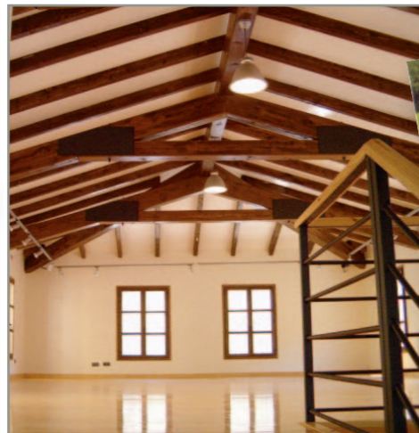
• Aspecto anterior a la intervención
