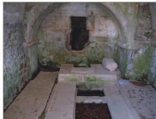
❖ Aspecto anterior a la intervención
