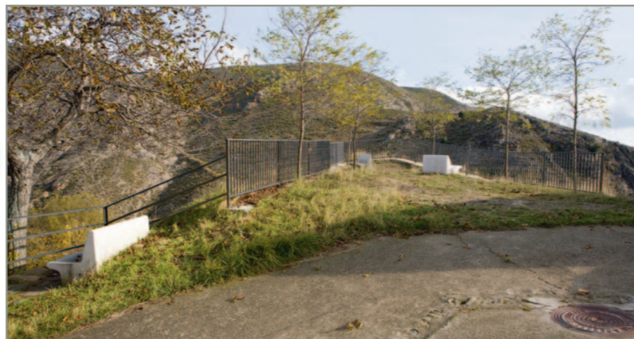
•• Aspecto al término de la intervención
