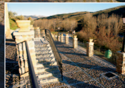
Detalle de la intervención
