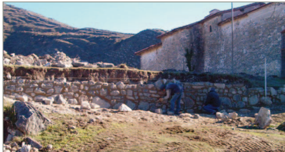
•• Proceso de intervención
