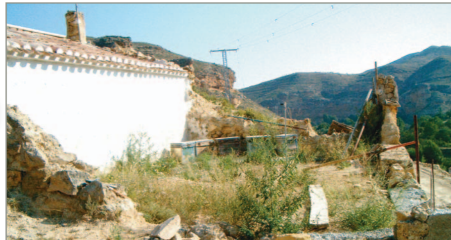
❖❖ Aspecto anterior a la intervención
