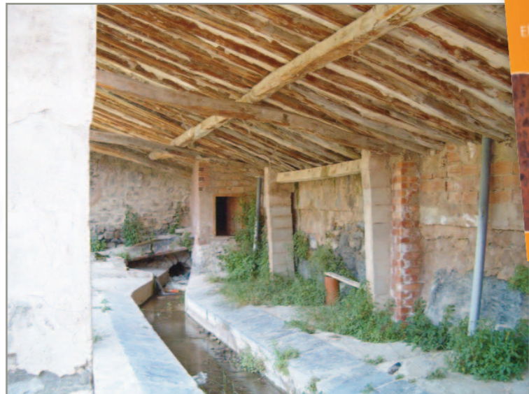
Aspecto anterior a la intervención
