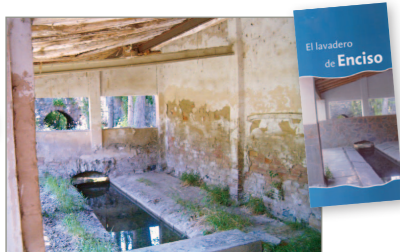
• Aspecto anterior a la intervención
