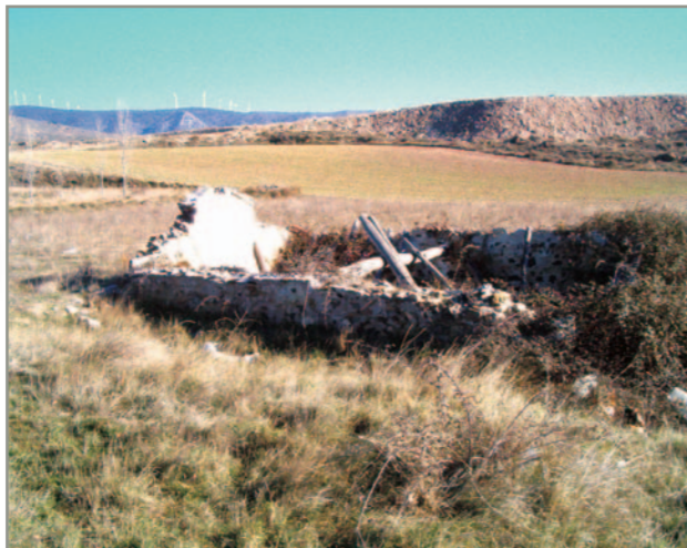
Aspecto anterior a la intervención
