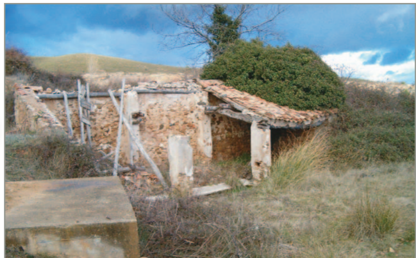
Aspecto anterior a la intervención
