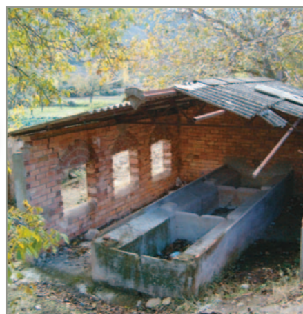
•• Aspecto anterior a la intervención
