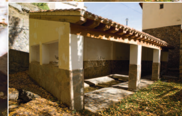
• Detalle de la intervención
