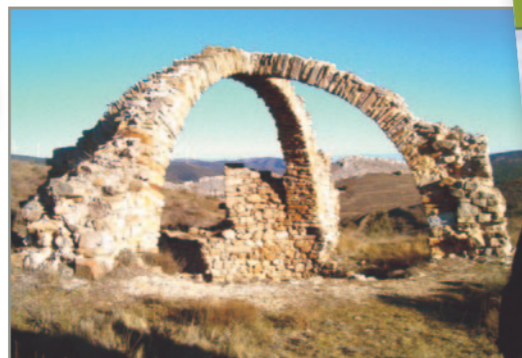
❖ Aspecto anterior a la intervención
