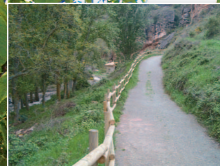
•• Detalle de la intervención
