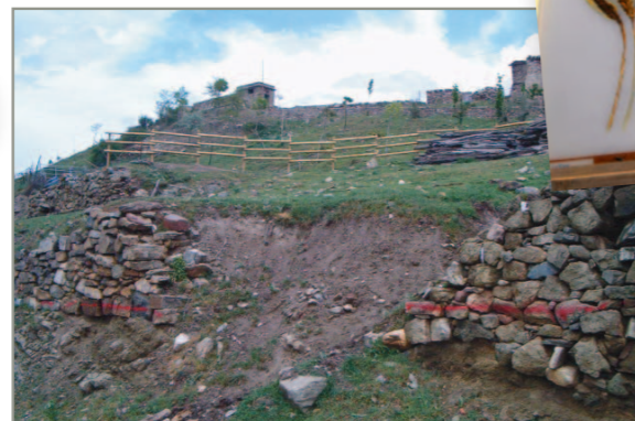
❖❖ Aspecto anterior a la intervención
