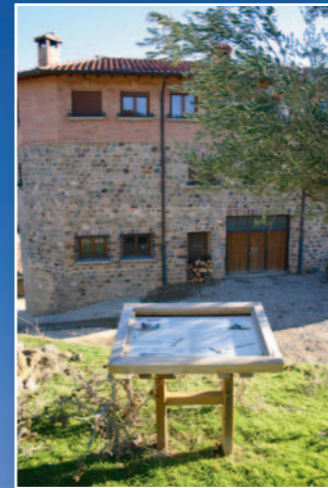
❖❖ Detalle de la intervención
