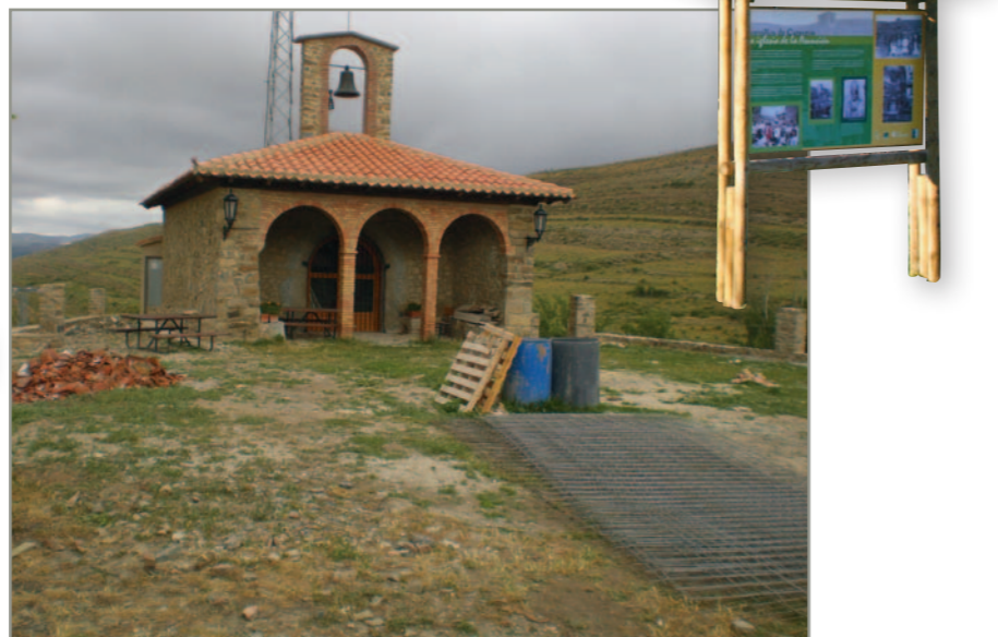
•• Aspecto anterior a la intervención
